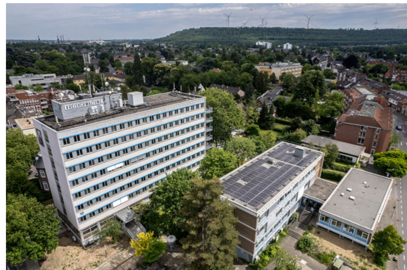
Abbildung 6-9: Kreisverwaltung Rhein-Kreis Neuss mit PV-Anlage
